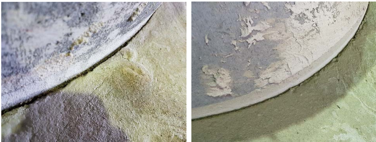
Bild 17 Spalt zwischen Flüssigboden (ZFSV) und Abwasserschacht bei Material „Terrapact“ (links) und Material „carbofill“ (rechts)
