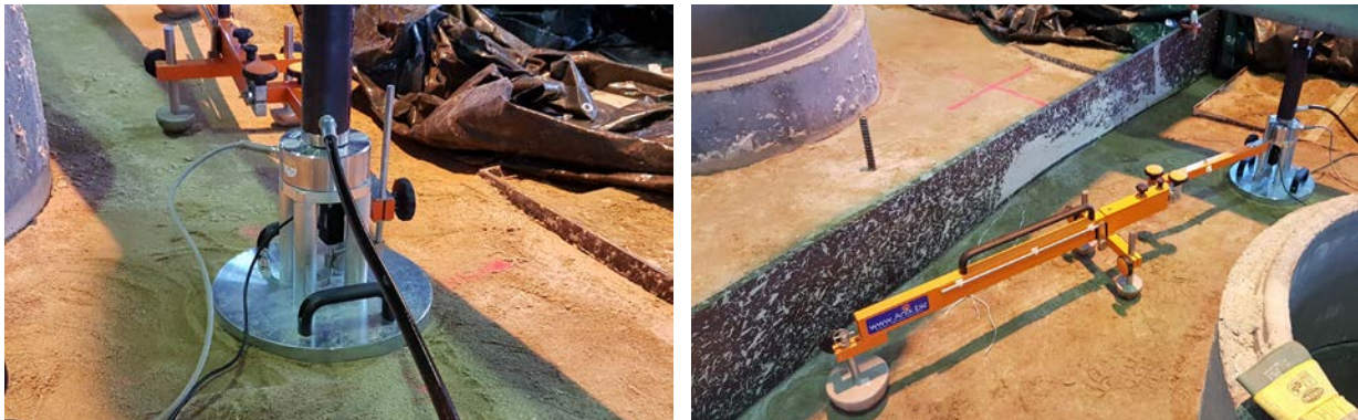
Bild 15 Prüfung mittels Lastplattendruckversuch für das K.O.-Kriterium „Überbaubarkeit“
