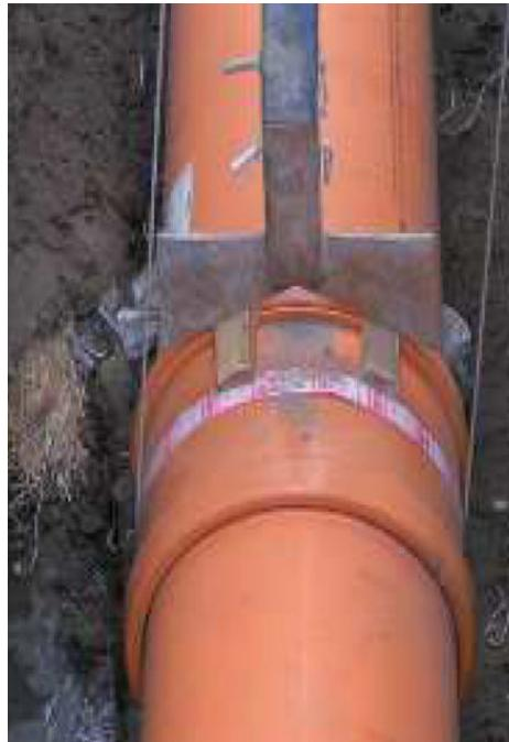
Установка трубы KG DN 500 в самой нижней части траншеи для трубопровода во время первоначальной выемки грунта "Голландский
