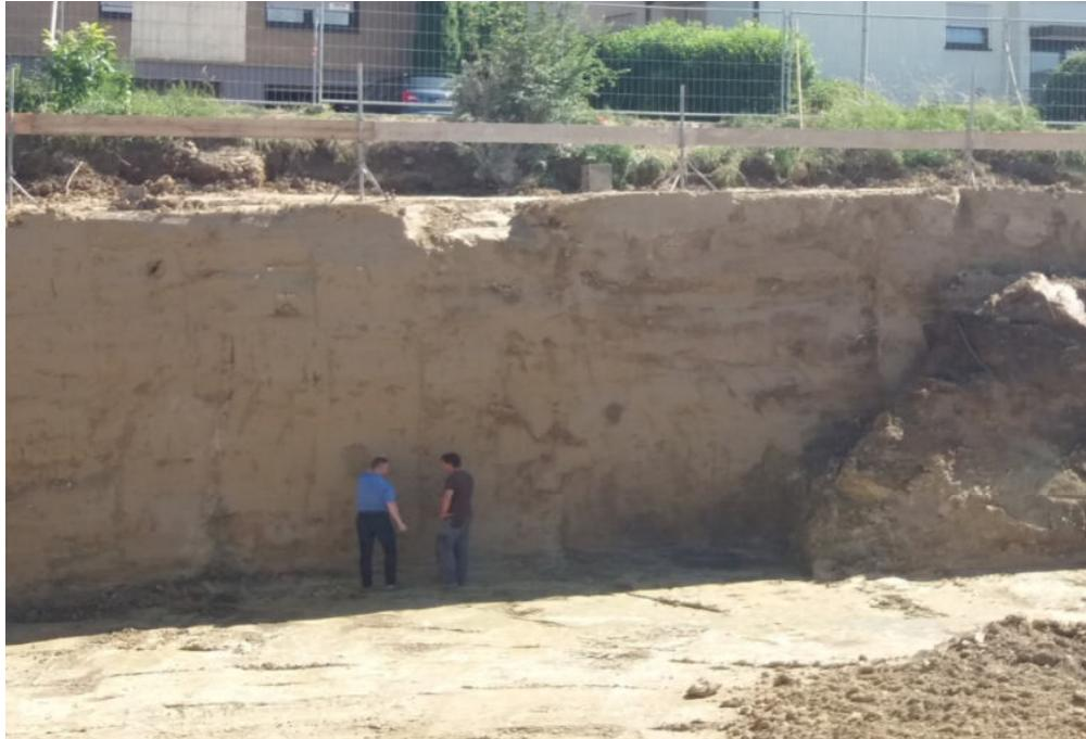
**Водонепроницаемый котлован:** в форме компактной стены RSS®, которая поглощает нагрузку от застройки и дорожного движения, как часть более поздней опалубки для бетонных работ, в сочетании с аналогично водонепроницаемой фундаментной плитой, которая также состоит из жидкого грунта RSS®, для создания водонепроницаемых и устойчивых к выпучиванию котлованов вместе со всеми необходимыми испытаниями, методами расчета и выполнением поверочного расчёта.
