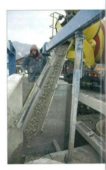
Nachdem z.B. neue Leitungen gelegt wurden, wird der zuvor ausgehobene und fließfähig gemachte Boden wieder verfüllt
